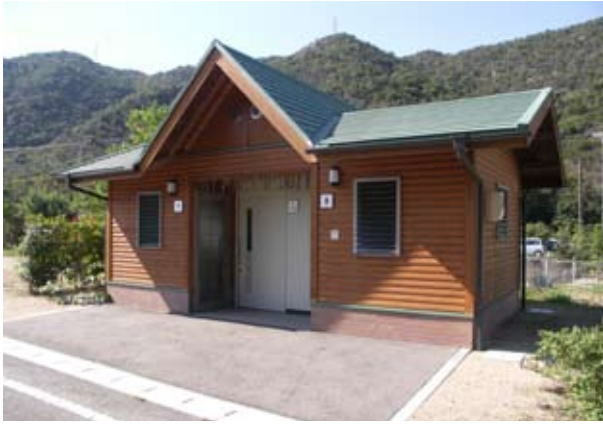
清水駅跡のトイレは、当時の駅舎を模したもの
