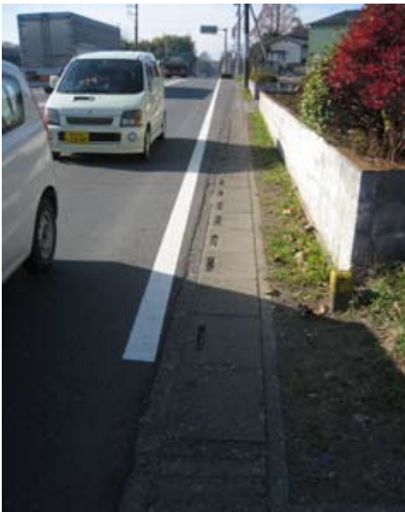
極端に狭く危険な自転車道(滑川町大里付近)
