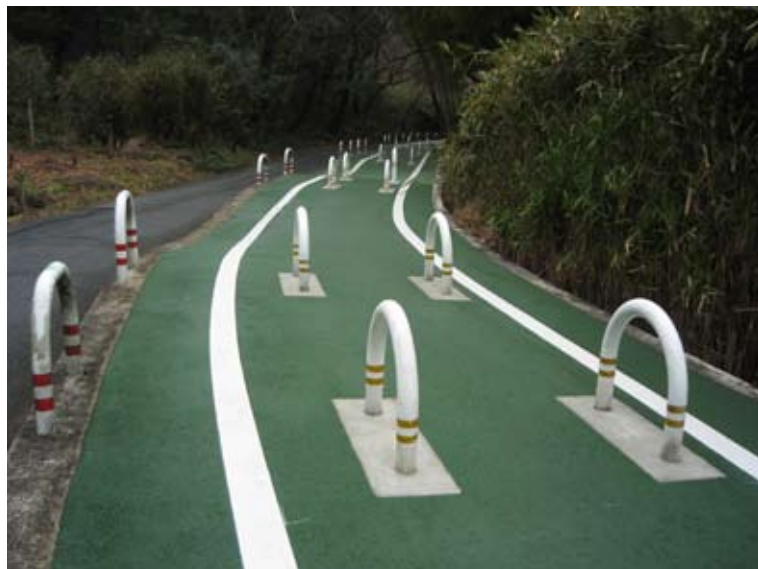
危険なガード（奈良ドリームランド跡裏付近）
