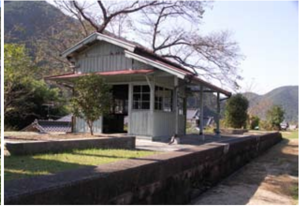
かつての駅舎が格好の休憩所となっている
