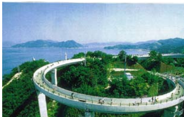
サンライズ横から来島海峡大橋までの取り付け道
