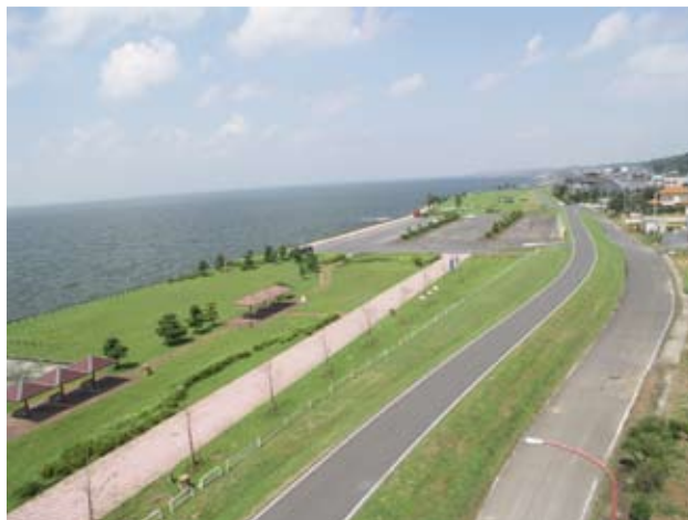
霞ヶ浦北岸に沿って延びる霞ヶ浦自転車道
