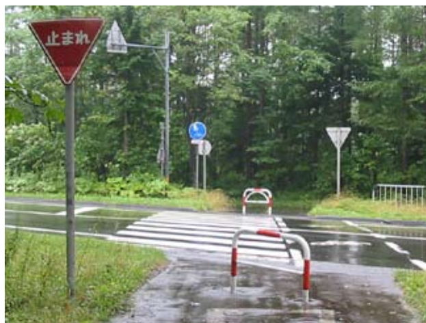
右を手前に、斜め位置で設置されたクルマ止め
