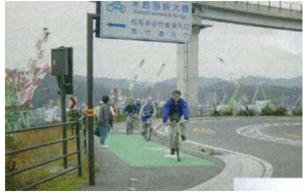
案内標識設置状況
