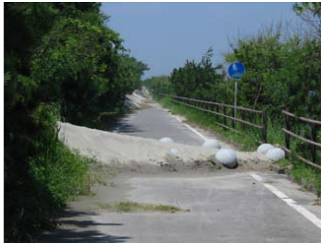
砂で路面が埋まり、通行不能となっている自転車道
