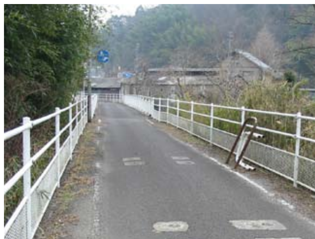
撤去され、道ばたに放置されたクルマ止め
