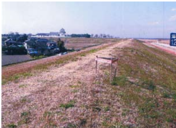
舗装希望箇所②（利根川右岸、海から 120.5km）
