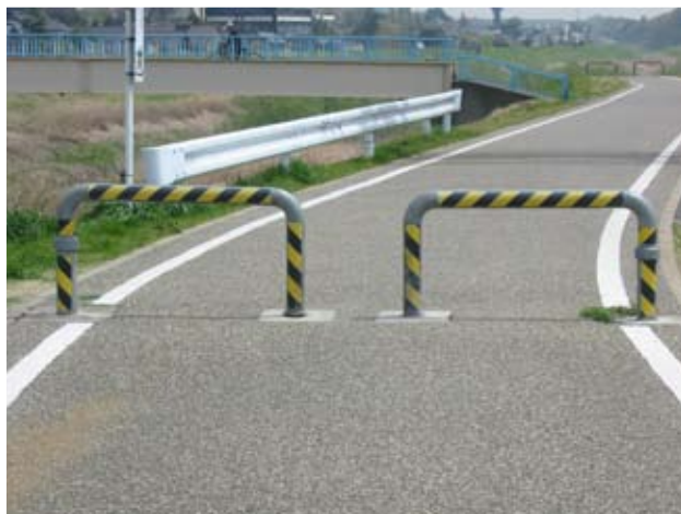
並べて設置されたクルマ止め
