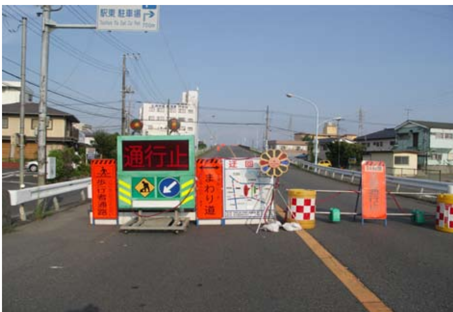
写真 30 当日は通行止めとなっていた川口跨線橋も調査した
