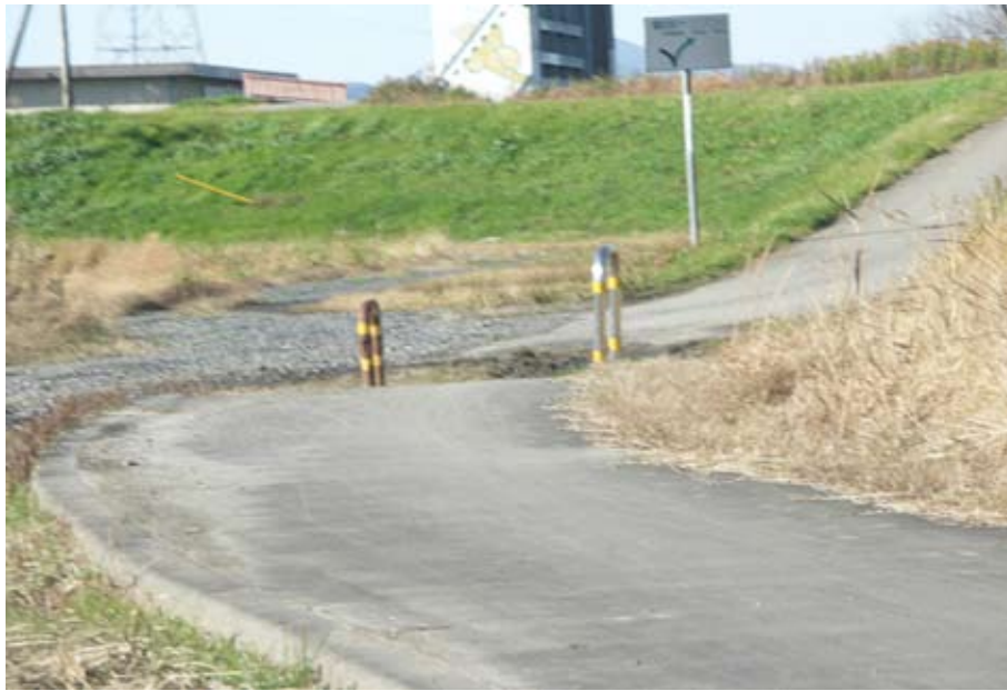
写真 18 車止めや案内標識は、新旧が混在している
