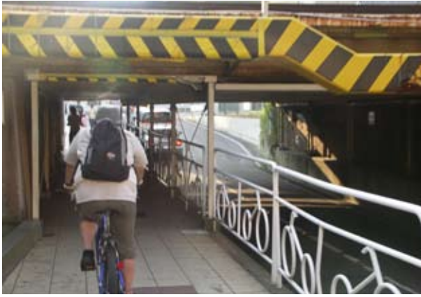
⑤ 2つの自転車道をつなぐルート（反対側から）
