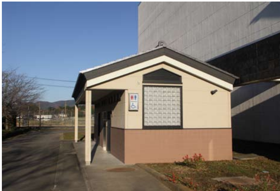
写真 24 終点となる中央公民館の敷地内にトイレがあり、いつでも利用できる
