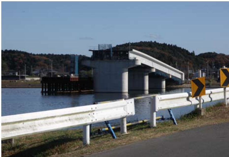
写真10 国道354号線の鹿行大橋は、現在架け替え工事中
