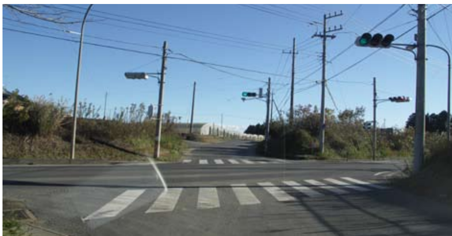
写真6 未整備とされているため、道筋を示す案内標識もない
