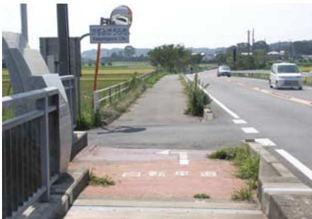
①霞ヶ浦大橋を渡って左折が霞ヶ浦自転車道。右折は霞ヶ浦サイクリングコースとなるが、ここにはそれを示す標識はなく、横断歩道も存在しない
