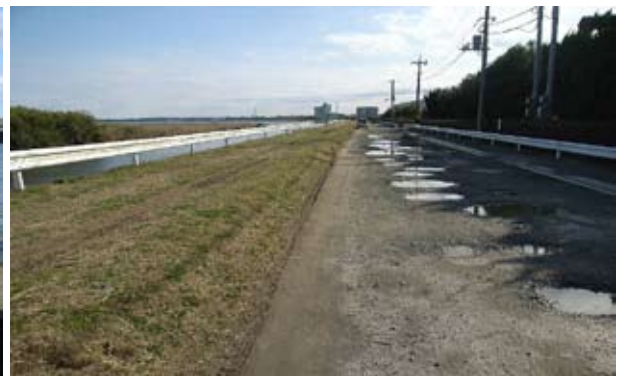
⑫ 幅員が広い代わりに舗装はされていない
