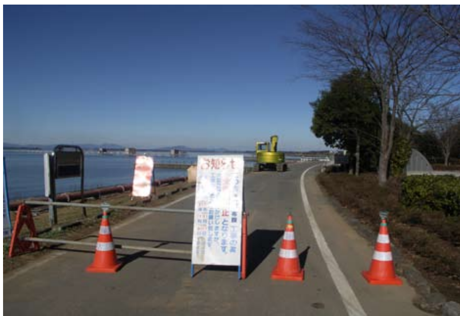
写真 13 霞ヶ浦大橋から先の湖岸（高浜入左岸）沿いの道は工事中で通行ができない
