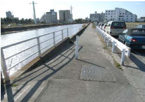
⑨ 新川に沿った歩道。柵がないため落下に注意
