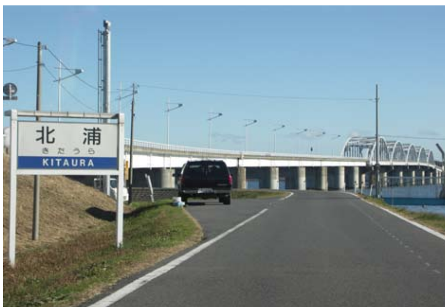
写真8 北浦大橋との交差は、橋桁の下をくぐることができるためスムーズ
