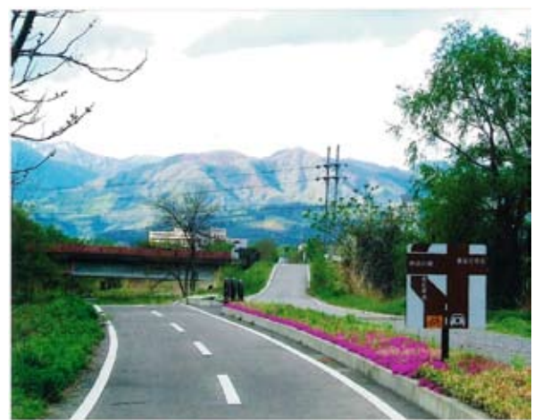
(福島県喜多方市) 完全に分離された自転車道
