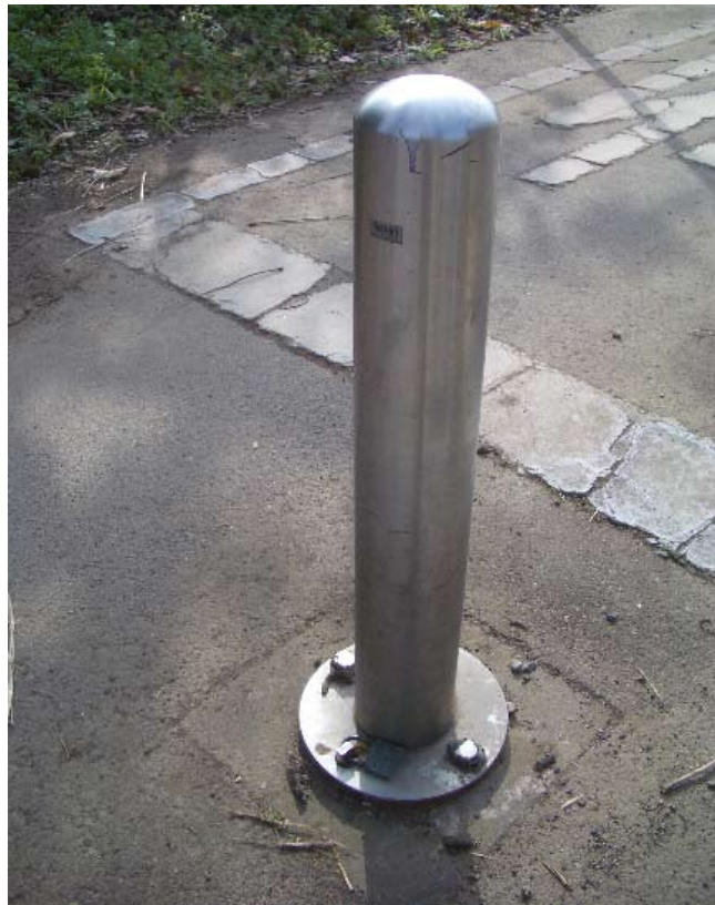
写真3 ポール・タイプ。ロックを外すことにより、脱着できるようになっている
