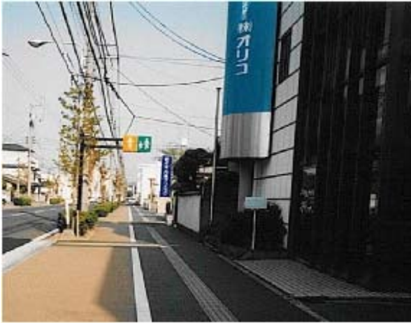
図11 香川県高松市 市道片原町沖松島線 図12のケースと路面色が逆なので、サインの色も逆になっている
