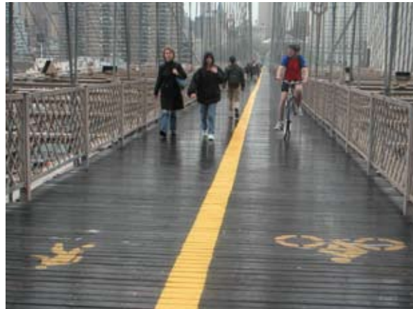
歩行者と自転車が明確に分離されたブルックリンブリッジ
