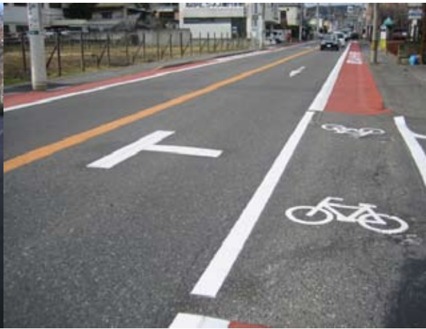
(長野県松本市) 自転車レーンを横切る交差点の明確化
