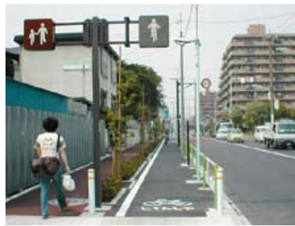
(東京都板橋区) 分離植栽帯を設置
