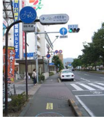
(長野県長野市) 縁石により駐車をブロック
