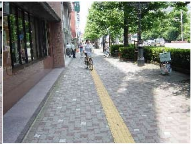
図8 新潟県新潟市一般国道7号（東大通り） 自転車通行部分と歩行者通行部分の区分に点字タイルを使っているが、色彩が同一で区別できない
