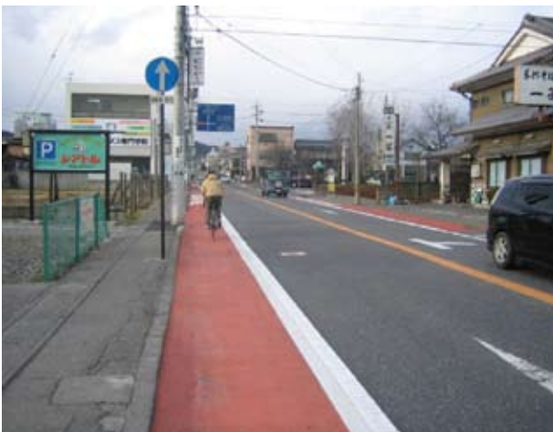
図1 茶系：長野県松本市 市道 1223 号線 複断面道路の車道側に自転車通行帯を設置した ケース。通行帯が茶色に塗装されている
