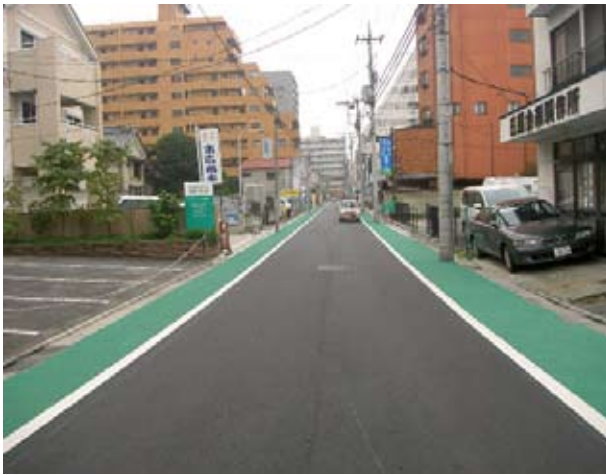
図3 緑系：栃木県宇都宮市 市道1137号線 単断面道路の緑部分が自転車歩行者通行帯であるが、他地区ではまったく同色で通学路のケースも
