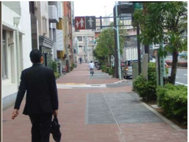
図6 グレー・アスファルト系：東京都浅草通り 図5と同様の色彩であるが、インターロッキングのためコントラストがはっきりしない
