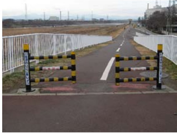
写真②多摩川左岸・上流側
