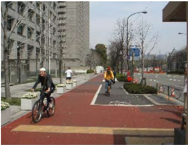
図5 グレー・アスファルト系：東京都霞ヶ関 ここで自転車通行帯＝グレー、歩行者通行帯＝茶系が実施され、東京都でのモデルとなった
