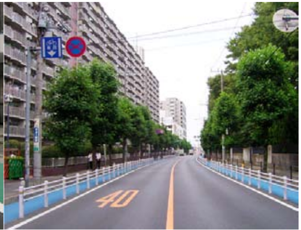
図4 青系：埼玉県志木市 主要地方道保谷志木線 車道側に柵で分離して設置された青色の自転車通行帯。車道と同じく左側一方通行である
