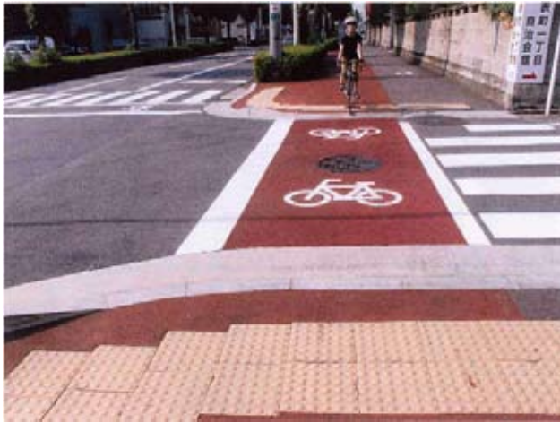
(群馬県前橋市) カラー舗装された自転車横断帯
