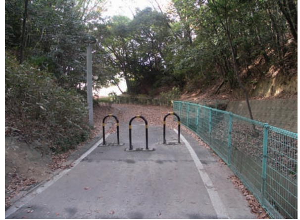
同じく互い違いに置かれたクルマ止め。パイプが細い分を反射テープで補っている。やはり重なっている部分はないため、さほど無理なハンドル操作を強いられることはない。ただし、この箇所を設置する必然性が不明である。
