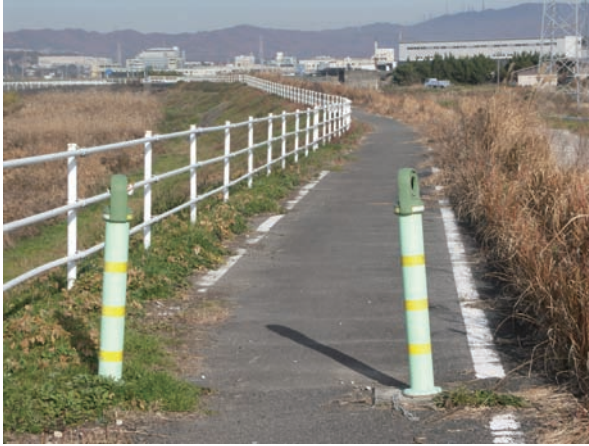
円柱形のクルマ止めで、視認性は十分である。
