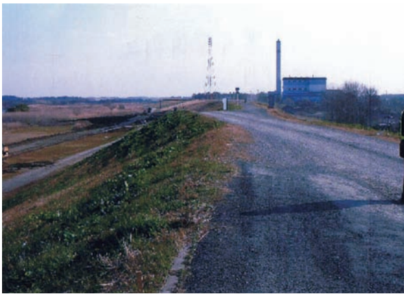
舗装希望箇所①（江戸川右岸海から 54.8km）
