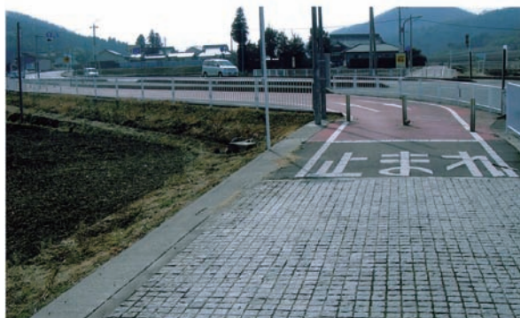
クルマ止めの手前でわざと振動を起こして気づかせる舗装
