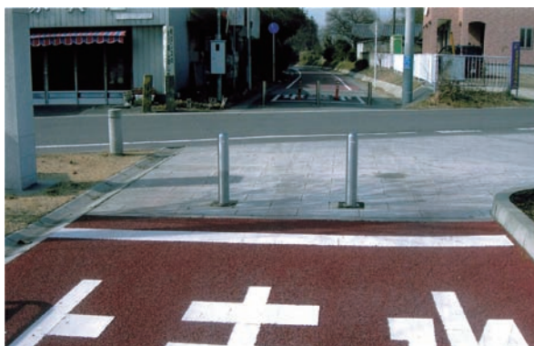
一般道横断箇所は舗装を変えて注意を促す
