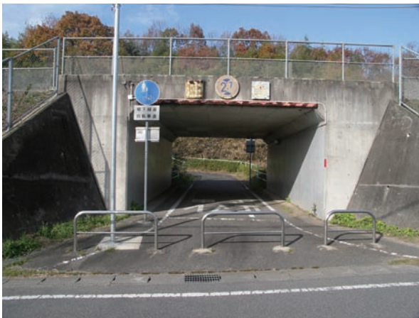
形状は一般的な逆U字形で、反射テープが巻かれていないため夜間の視認性は劣ることと、パイプそのものが細いため、逆U字形にしては視認性が劣る。ただし、路面に「止まれ」の標示があって、視認性の低さを補っている。
