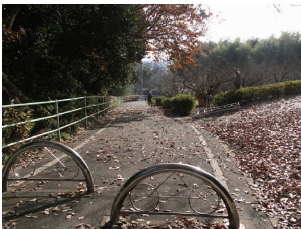
互い違いに置かれたクルマ止め。重なっている部分はないため、さほど無理なハンドル操作を強いられるこ
